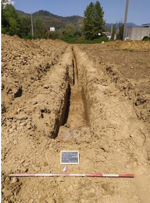
Trinca 2 particolare in fase di scavo.
